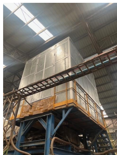
รูปที่ 2.1-9 ห้องเก็บ Battery Breaker เพื่อลดเสียงจาก แหล่งกำเนิด
