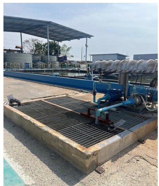
รูปที่ 2.1-18 รูปท่อรวบรวมน้ำฝนบนเพื่อก่อน ก่อนเข้าระบบบำบัดน้ำเสีย
