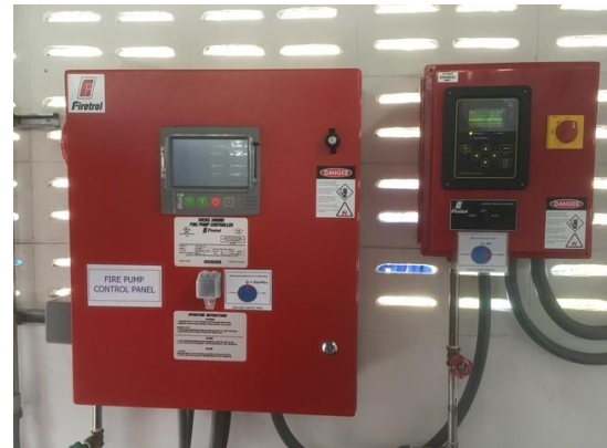
รูปที่ 2.1-37 ระบบเครื่องสูบน้ำดับเพลิง ระบบ Vertical pump
