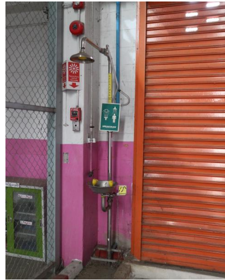
รูปที่ 2.1-31 ที่ชำระล้างสารเคมีอันตราย ที่ล้างมือและล้างหน้า
