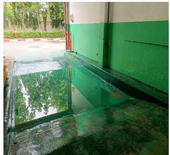
รูปที่ 2.1-16 บ่อล้างล้อบริเวณห้องเก็บซากแบตเตอรี่
