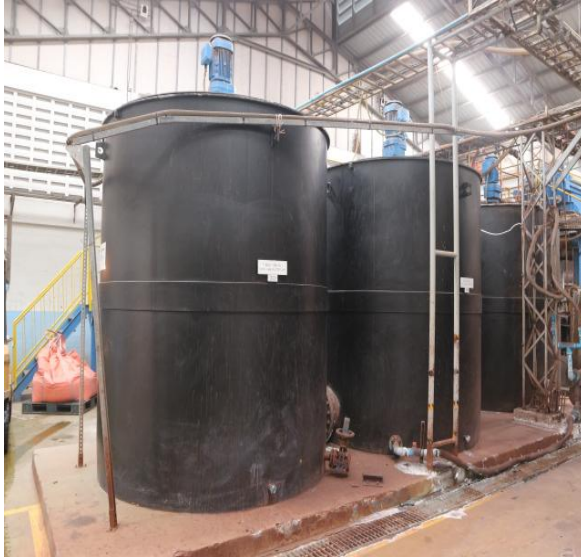
รูปที่ 2.1-13 ระบบบำบัดน้ำกรด Electrolyte Treatment Plant
